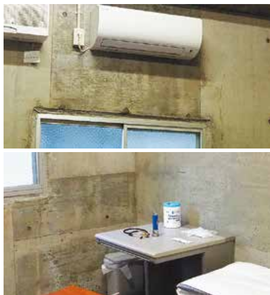
カルテ用倉庫に換気扇、エアコンを設置(上)、発熱外来の診療室を確保(下)。費用は約50万円
