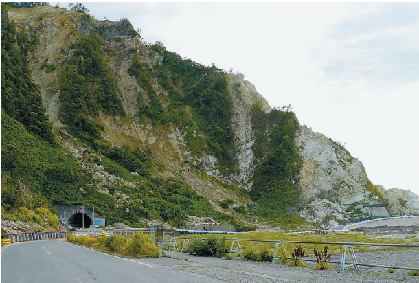
逢坂トンネル(珠州市)の崩落現場。トンネルのある岬全体が崩落しており、岬の先の隆起した海岸部分に仮設道路が盛土して迂回するように建設されている(8月8日撮影)
