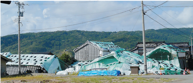
今も残る倒壊家屋(輪島市黒島地区の重要伝統的建造物群保存地区、8月7日撮影)
