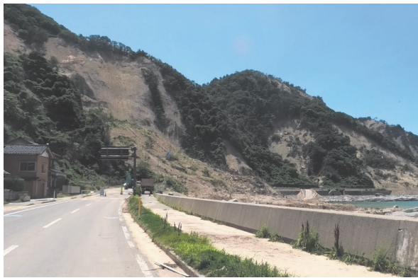
地震と豪雨で通行止めが続いた珠州市の日本海側の幹線道路 (24 年 7 月末撮影)。今年 8 月の大雨でまたも「当分の間」通行止めだ。
